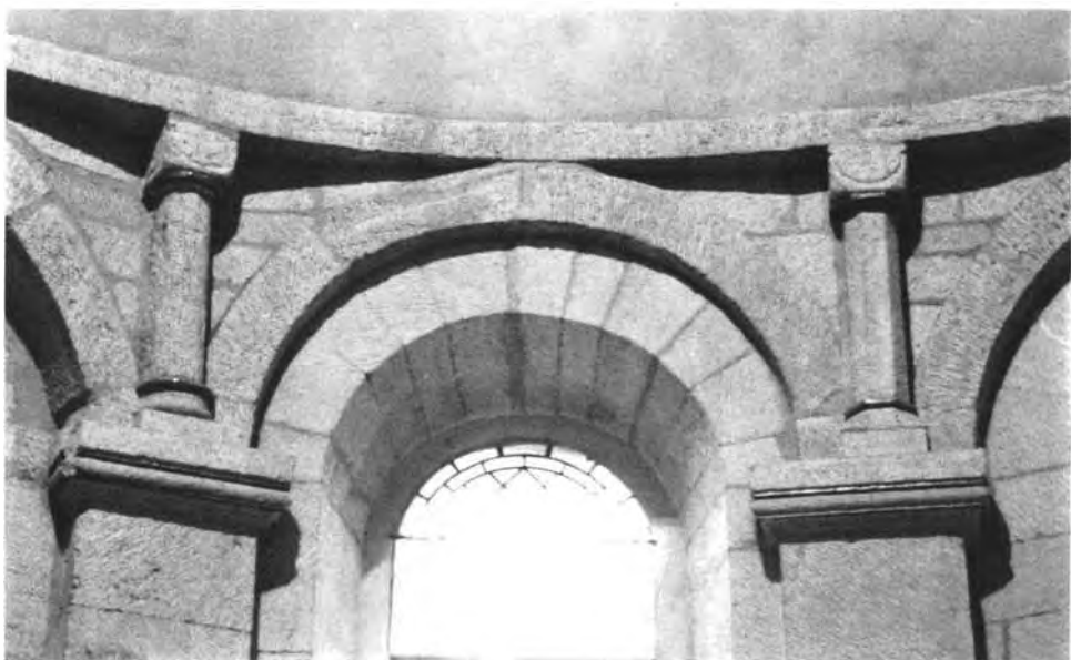
Église de Thicourt. Détail du chœur. (Cliché A.-M. Dufour)
